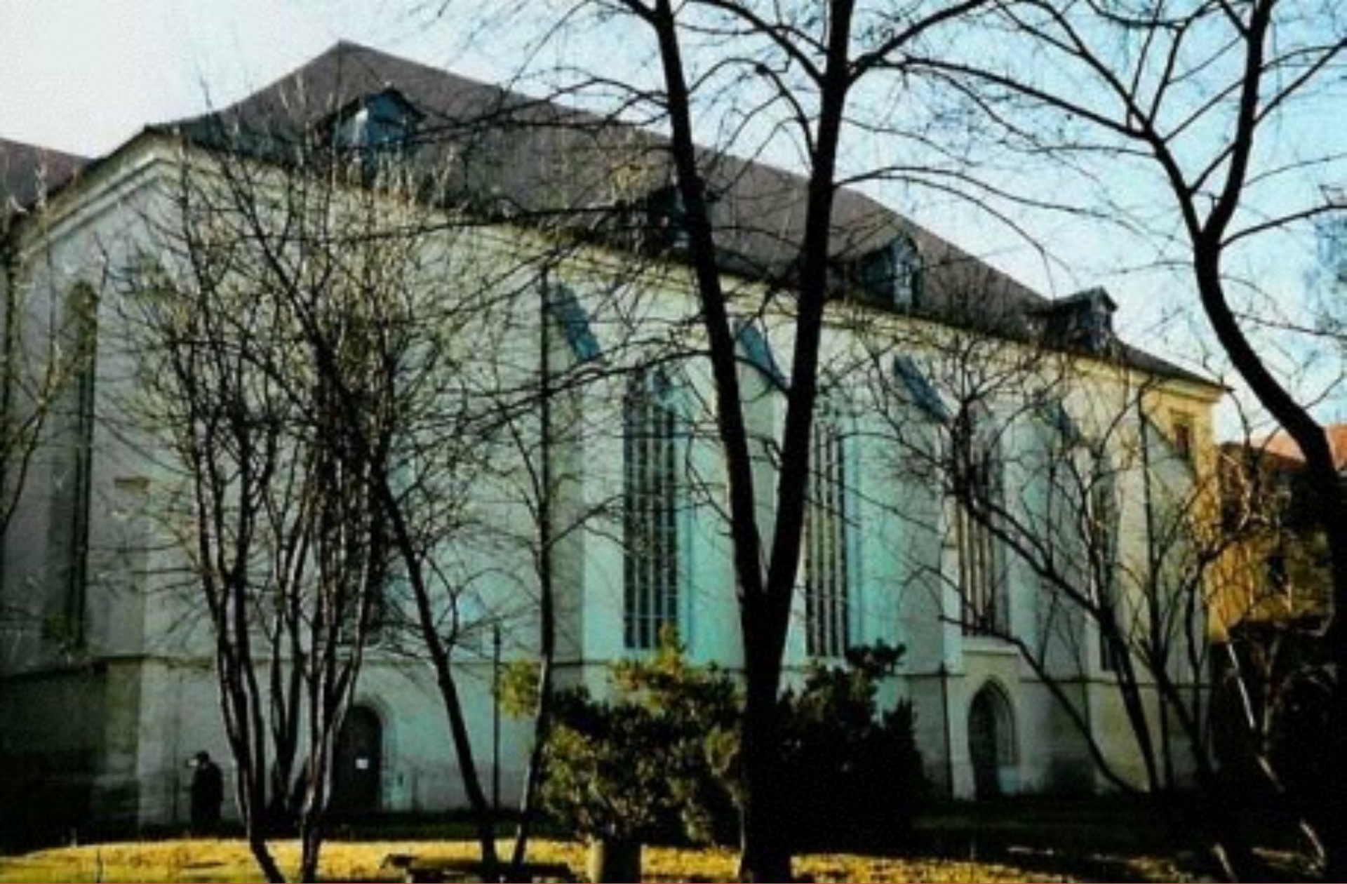
Zeitz, a kastélyhoz épült dóm épülete
